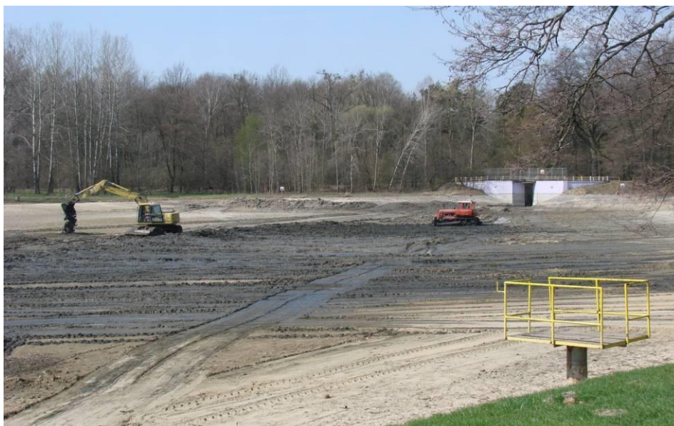
Rysunek 19. Usuwanie osadów dennych ze zbiorników w Arturówku
