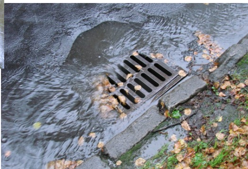
Kratka burzowa odprowadzająca wodę bezpośrednio do koryta rzeki Bzury.
