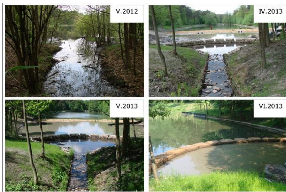
Ryc. 2. Proces ekohydrologicznej adaptacji czaszy zbiornika Arturówek Górny w Sekwencyjny System Sedymentacyjno-Biofiltracyjny jako jedno z działań wykonanych w ramach projektu EH-REK
