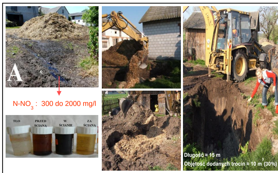
Ryc. 4. Etapy konstrukcji złoża denitryfikacyjnego do rekultywacji punktowych źródeł zanieczyszczeń
