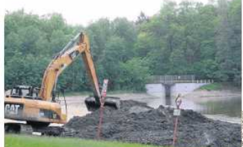
Przebudowę stawów w Arturówku
