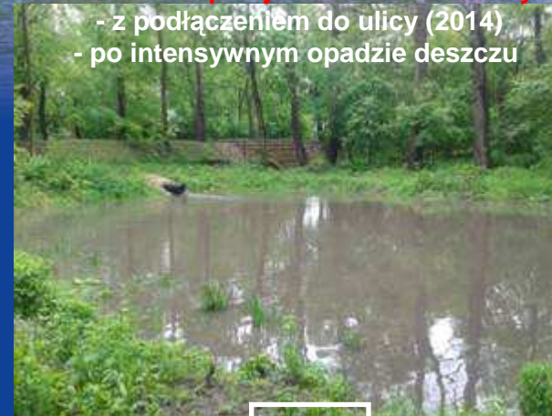
zbiornik do przejmowania wód z ulicy - z podłączeniem do ulicy (2014) - po niewielkim opadzie deszczu
