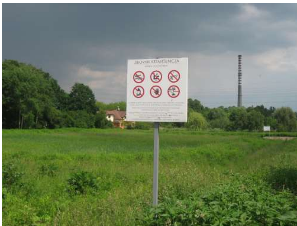
Rys. 19 Zbiornik retencyjny zlokalizowany w dolinie rzeki Olechówki na wysokości ul. Rzemieślniczej.
