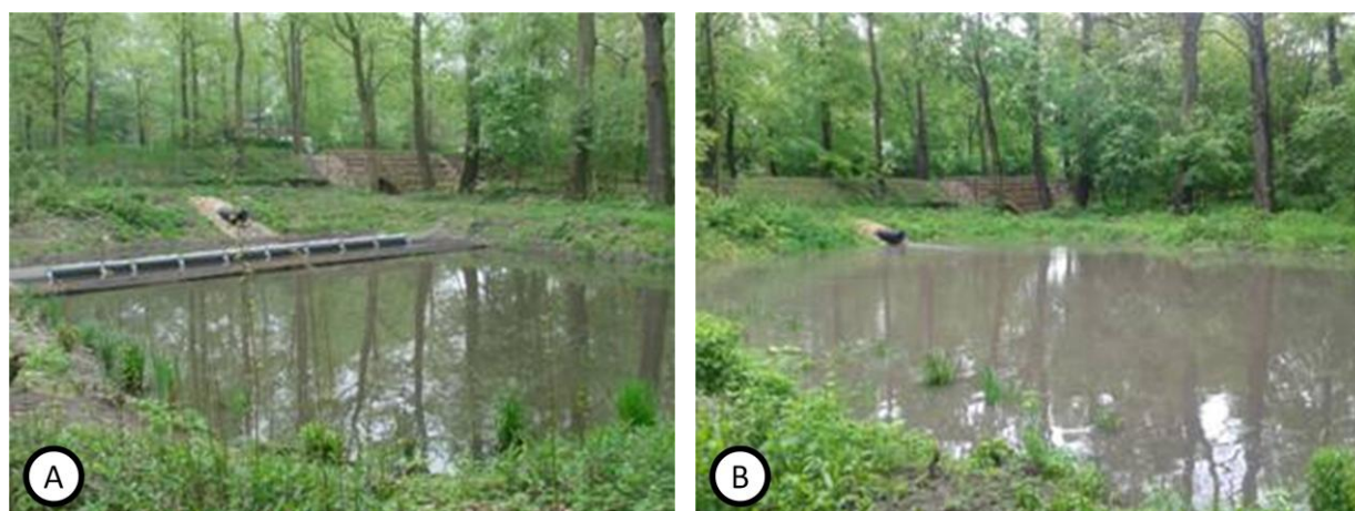
Rys. 14. – Stan wód w SSSB po: A – niewielkim opadzie deszczu; B – intensywnym opadzie deszczu (fot. T. Jurczak)
