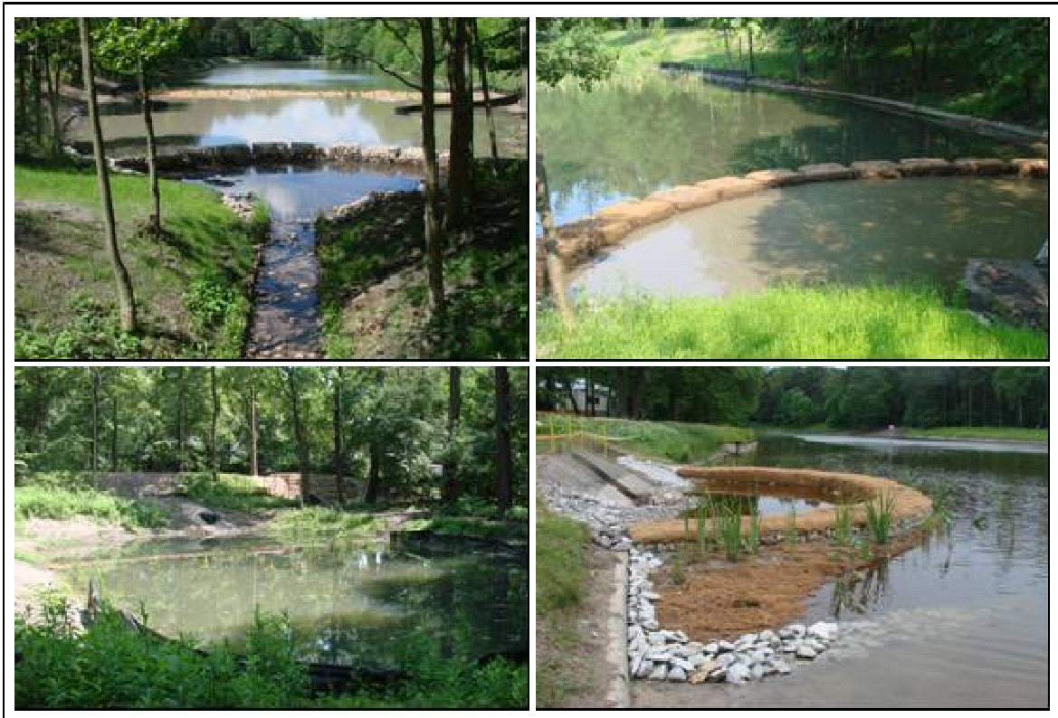
Przykłady zrealizowanych inwestycji w ramach projektu EH-REK w zbiornikach w Arturówku (fot. T. Jurczak, 2013)
