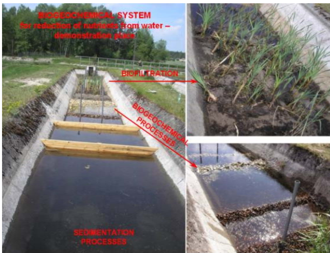
Fot. 1. Miejsce przekształcania istniejącego zbiornika górnego „Arturówek” w górnej jego części (fotografia górna) w systemy biofiltrów/wetlnadów, które pełnić będą rolę systemu sedymentacyjno-biofiltrującego (fotografie poniżej), testowanego obecnie w stacji terenowej Uniwersytetu Łódzkiego.
